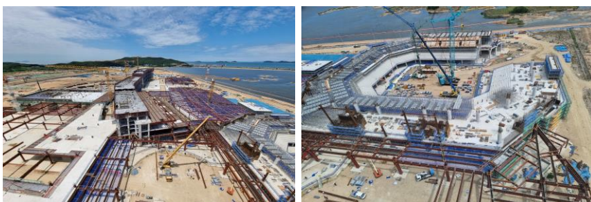
초기 인스파이어 리조트 공사 현장
